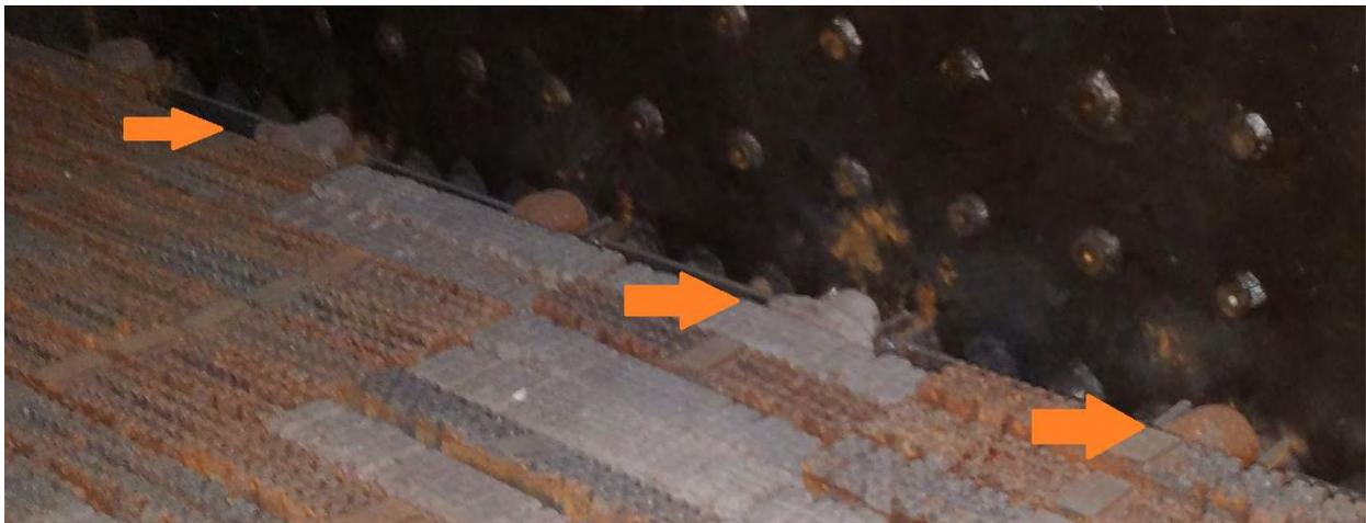
13) **Rigid Bolt Telltale Holes Drilled From Both Sides**
